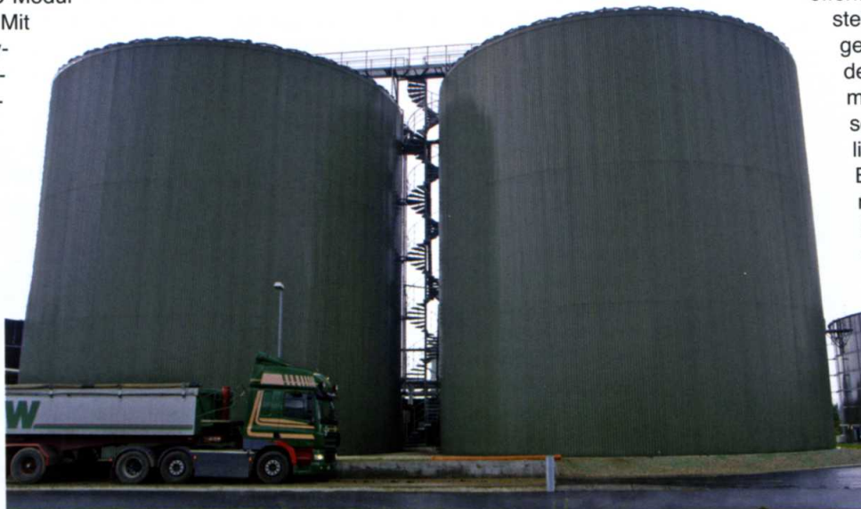
Als Substrate werden in Hennstedt hauptsächlich Rindergülle und Maissilage eingesetzt. Die Verweilzeit in den Fermentern beträgt jeweils 46 Tage.
